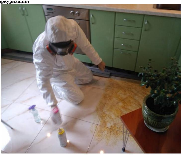
20 июля расчет радиационной и химической разведки Центра привлекался для проведени замеров концентрации паров ртути по адресу: г. Москва, ул. Голубинская. В ходе проведения работ проведена демеркуризация загрязненного участка, при повторном замере превышение ПДК паров ртути не зафиксировано.
