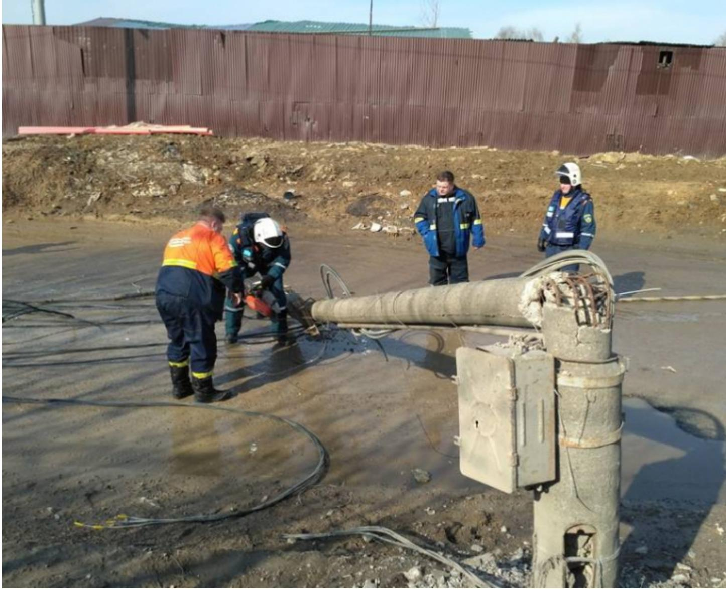
10 апреля дежурная смена Центра привлекалась для ликвидации последствий падения железобетонной опоры линии электропередач на проезжую часть по адресу г. Москва, пересечение Проектируемого проезда и ул. Адмирала Корнилова. В ходе проведения работ организовано ограждение места происшествия, оказана помощь сотрудникам МОЭСК, произведен распил железобетонных конструкций и расчистка проезжей части.
