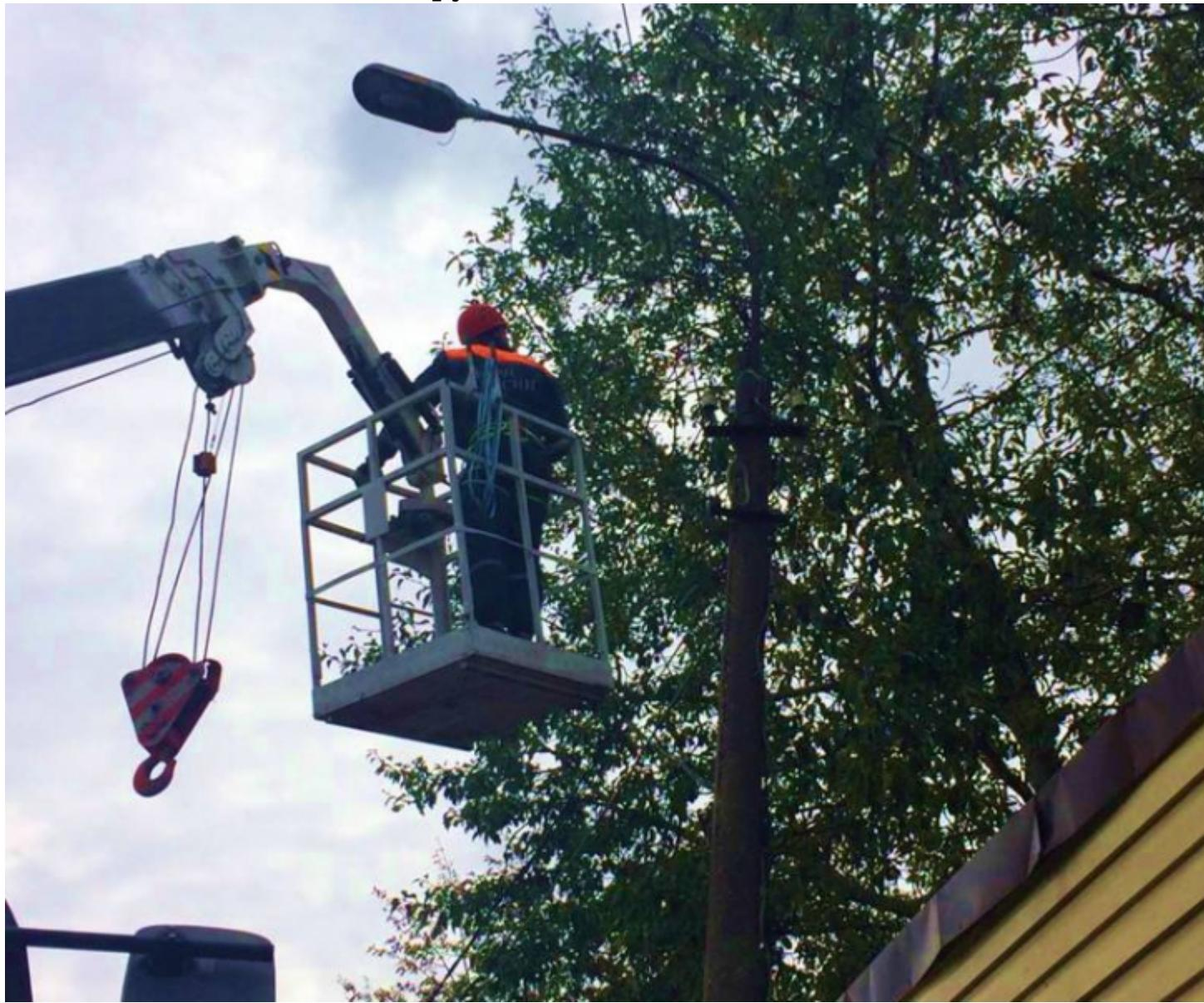
26 августа дежурная смена Центра привлекалась для демонтажа осветительной фонаря с воздушной линии электропередач по адресу: г. Москва, поселок завода Мосрентген, Проектируемый проезд, 133. В ходе проведения работ произведен демонтаж металлической конструкции плафона осветительного фонаря.
